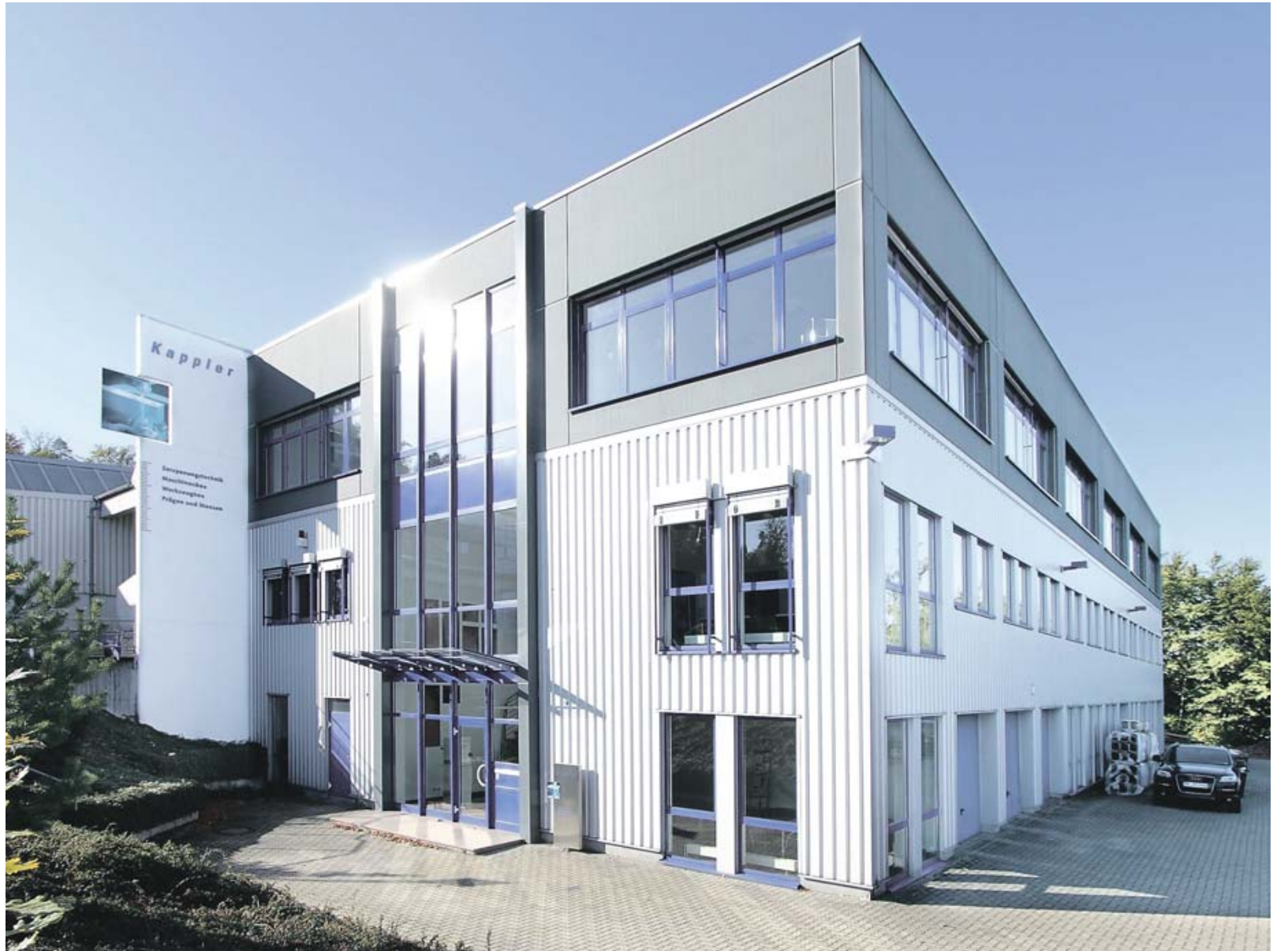
Perfekte Aufstockung – der erweiterte Bürotrakt der Kappler GmbH in Gräfenhausen.
